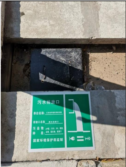
图 3-6 污水排放标识牌
